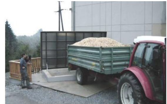
Volksschule St. Martin/W. mit Hackgutlageranbau
