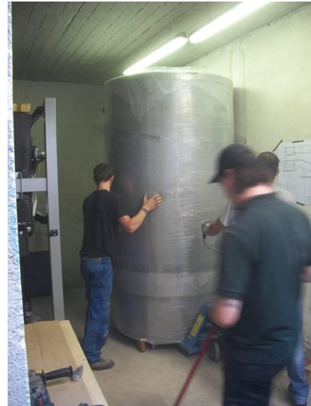
Montage Pufferspeicher
