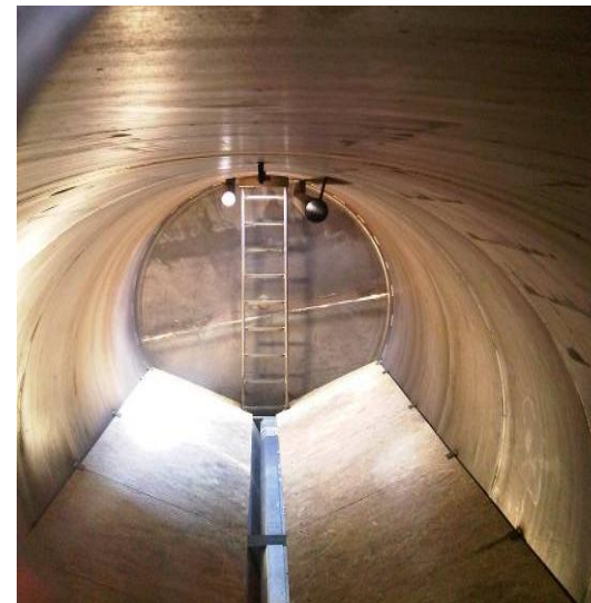
Pelletstank 40 m 3
